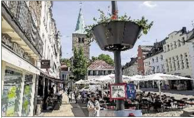
An allen acht neuen Laternenmasten beiderseits des Marktplatzes wurden am Dienstag Blumen-Halbschalen installiert
